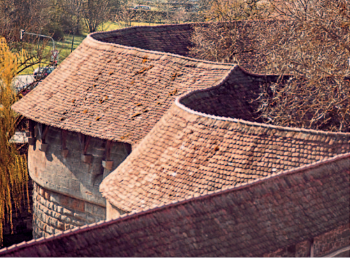
Geschwungene Dachfläche der Klingentorbastei
